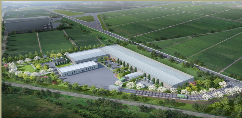
평택축협 가축분뇨공공처리시설 설치사업
