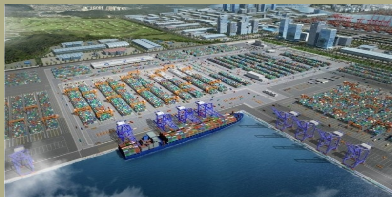
부산진해신항 컨테이너부두 1-1단계(2공구) 축조공사
