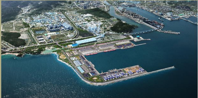
동해신항 기타광석부두 및 잡화부두 건설공사
