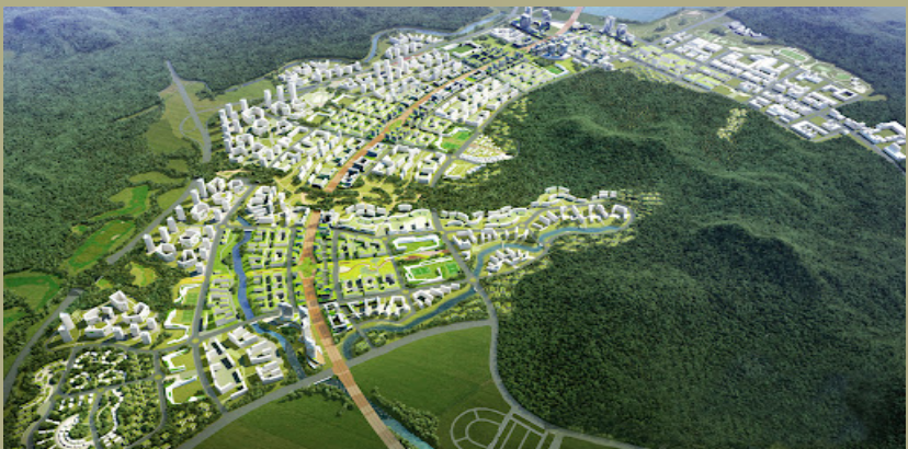
행정중심복합도시 6-2 생활권 조성공사
